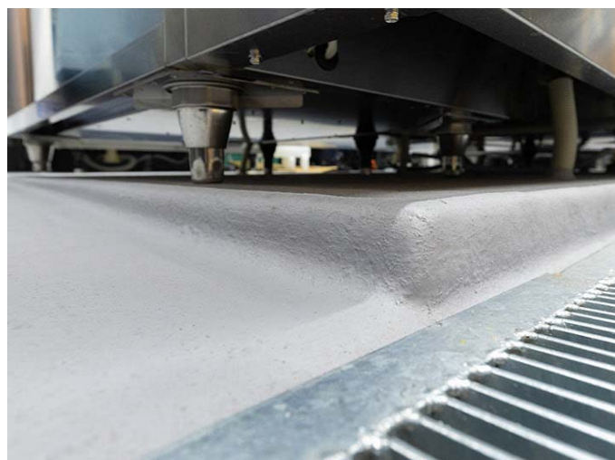
地板塗裝高防水性 FRP，考慮到清掃時的排水問題，設成向格柵蓋板傾斜。
